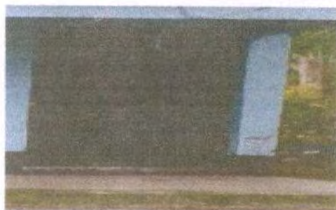
Foto 17: PINTURA DE PUERTA DE METAL
