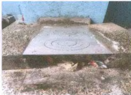
Foto 11: SUSTITUCION DE PLANCHAS DE METAL DE 3 HORNILLAS
