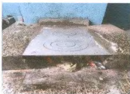
Foto 11: SUSTITUCION DE PLANCHAS DE METAL DE 3 HORNILLAS
