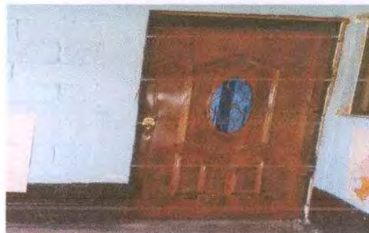
Foto 2: SUSTITUCION DE PUERTA DE MADERA POR METAL
