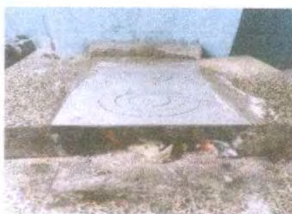
Foto 11: SUSTITUCION DE PLANCHAS DE METAL DE 3 HORNILLAS
