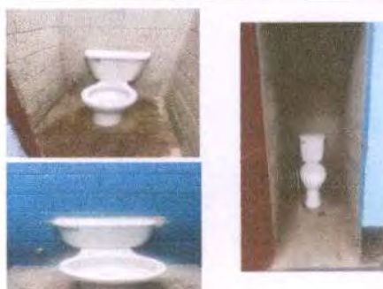
Foto 6: SUSTITUCION DE INODORO
