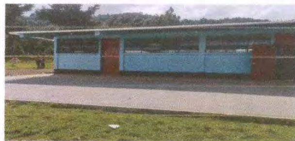
Foto 4: SUSTITUCION DE CANAL PVC
