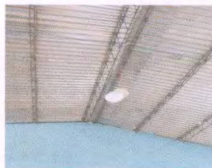
Foto 10: REPARACION DE LAMPARAS LED (INCLUYE CABLEADO)
