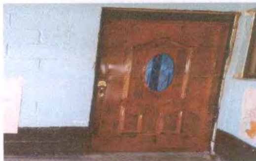
Foto 2: SUSTITUCION DE PUERTA DE MADERA POR METAL
