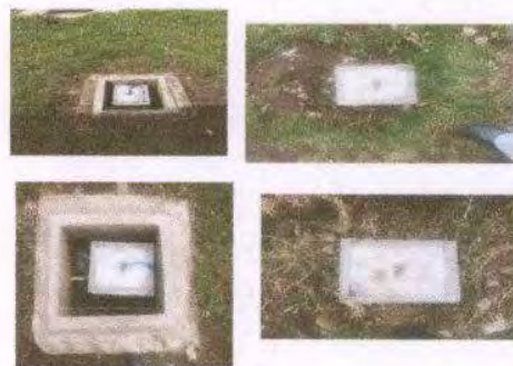
Foto 8: SUSTITUCION DE CAJA DE REGISTRO
