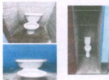
Foto 6: SUSTITUCION DE INODORO
