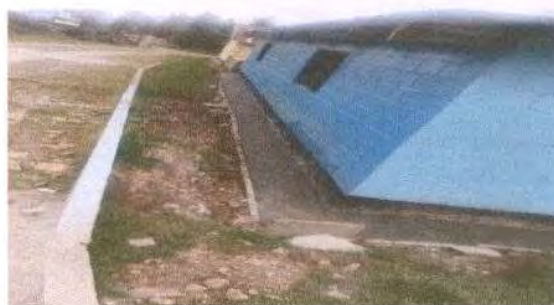
Foto 16: FUNDICION DE BANQUETA
