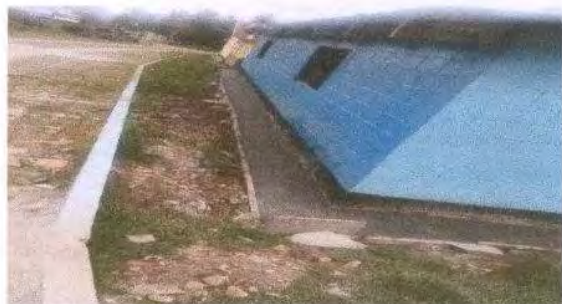
Foto 16: FUNDICION DE BANQUETA
