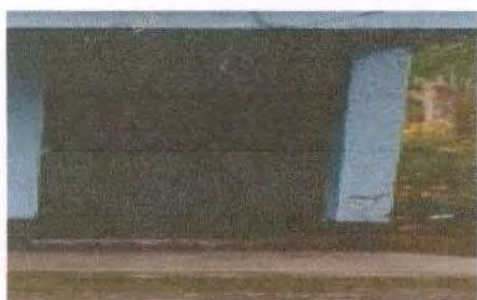
Foto 17: PINTURA DE PUERTA DE METAL
