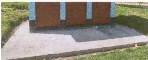
Foto 15: FUNDICION DE PISO FRENTE A SANITARIOS
