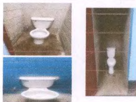
Foto 6: SUSTITUCION DE INODORO
