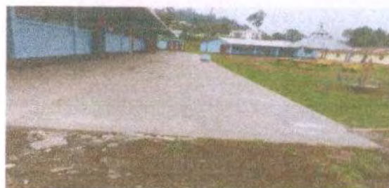
Foto 14: FUNDICION DE PISO
