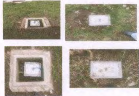
Foto 8: SUSTITUCION DE CAJA DE REGISTRO
