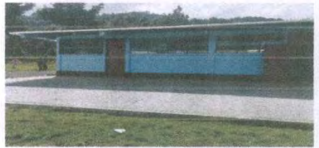
Foto 4: SUSTITUCION DE CANAL PVC
