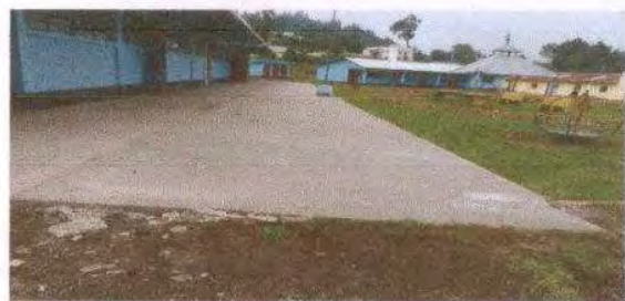
Foto 14: FUNDICION DE PISO
