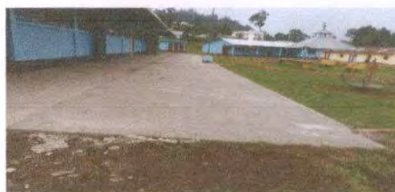
Foto 14: FUNDICION DE PISO
