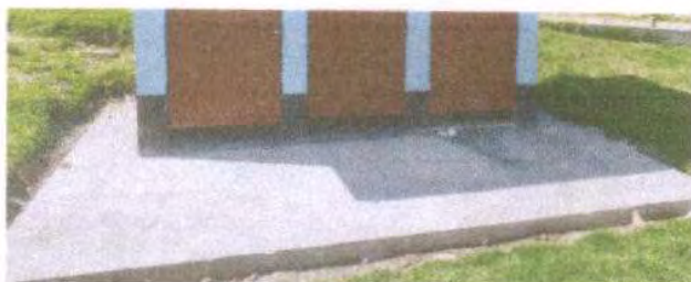
Foto 15: FUNDICION DE PISO FRENTE A SANITARIOS
