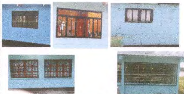
Foto 3: SUSTITUCION DE VENTANAS DE MADERA POR METAL MAS VIDRIO
