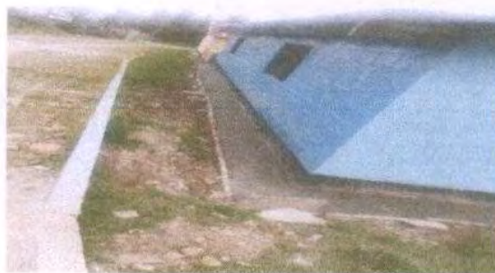
Foto 16: FUNDICION DE BANQUETA
