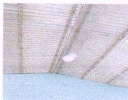
Foto 10: REPARACION DE LAMPARAS LED (INCLUYE CABLEADO)
