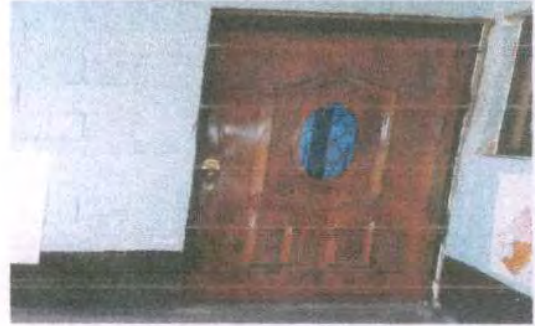
Foto 2: SUSTITUCION DE PUERTA DE MADERA POR METAL
